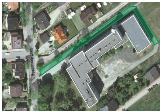
Teren przy Zespole Szkół nr 1, ul. Konopnickiej 56
